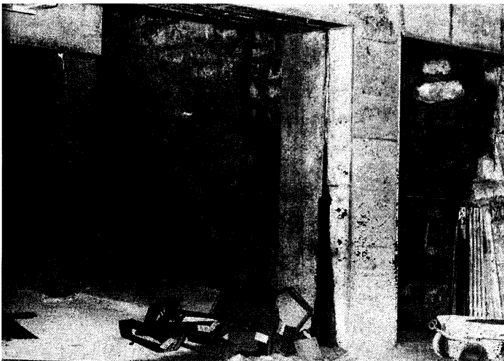
Vestige d'une tour d'enceinte, conservé dans le parking de la Banque.
