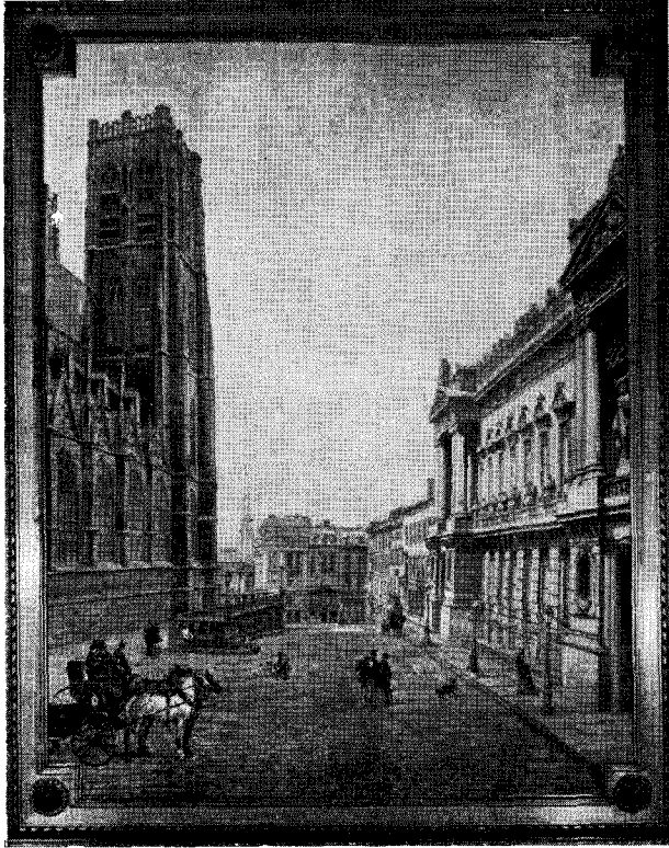
La façade de la Banque rue du Bois Sauvage (tapisserie de la salle des assemblées générales).
