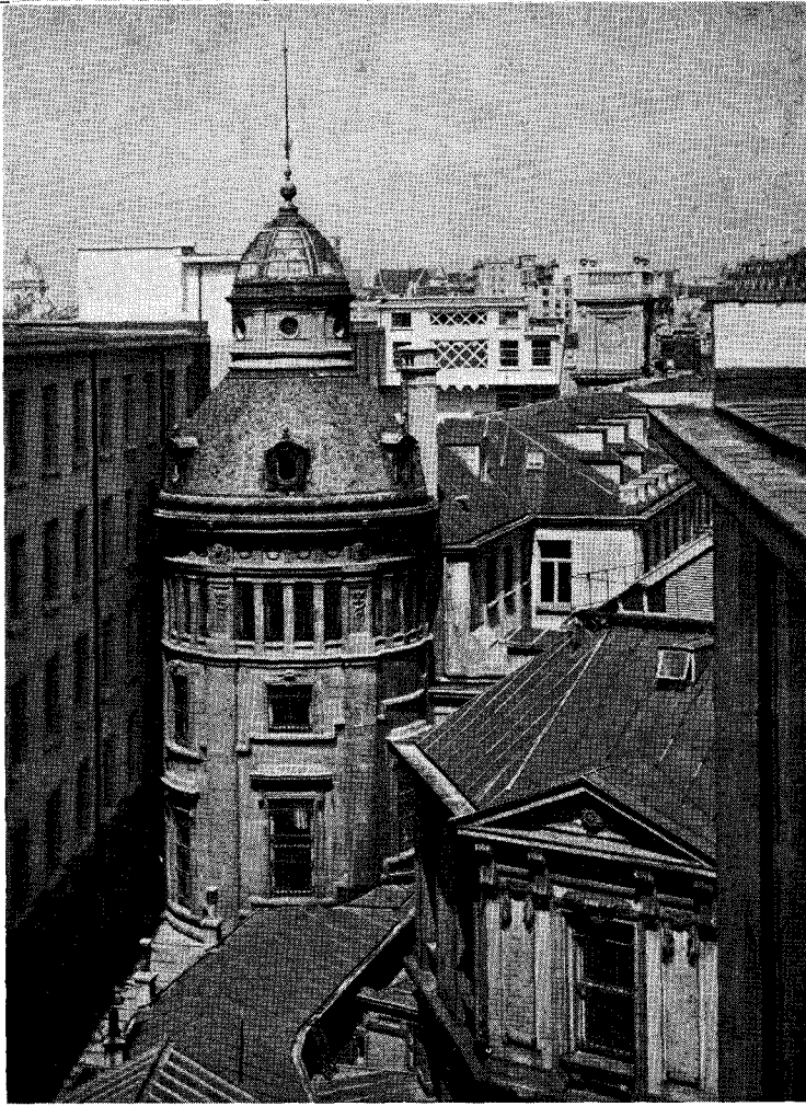
La « tour de Beyaert », encastrée dans les bâtiments nouveaux avant sa démolition.
