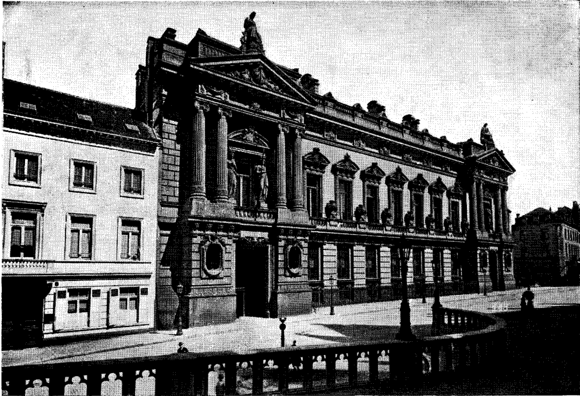
La façade de la Banque vers 1870.
